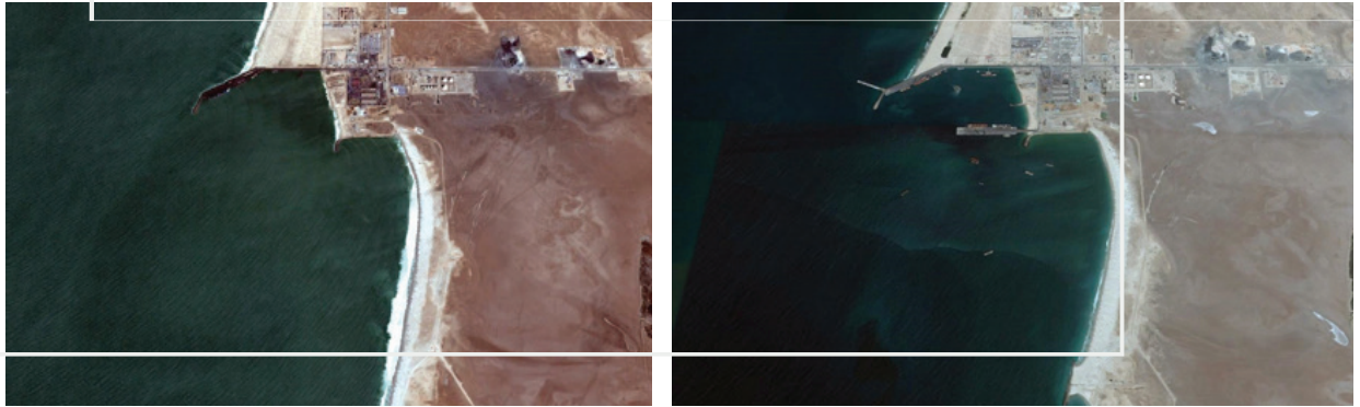
تطور ميناء نواكشوط والبنى التحتية المرتبطة به بين عام 2011 (في الأعلى) وعام 2015 (في الأسفل). وتتعلق أبرز التطورات بما يلي: '1' بناء رصيف جديد (2013)، '2' تمديد السد / سد الحماية 5 كم إلى الغرب و'3' بناء حضرة / جنوب ميناء للتخفيف من التعرية.
